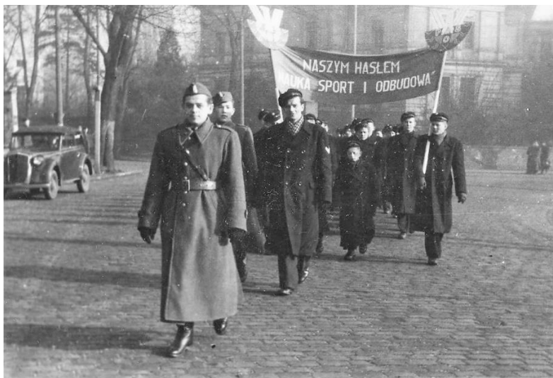
Fot. 2. Defilada w Szczecinie z wykorzystaniem propagandowych haseł. Pierwsza połowa lat pięćdziesiątych. Zbiory WKF i PZ US
