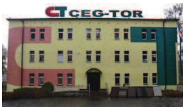
Ryc. 3. Budynek biurowy firmy CEG-TOR wraz z logo
