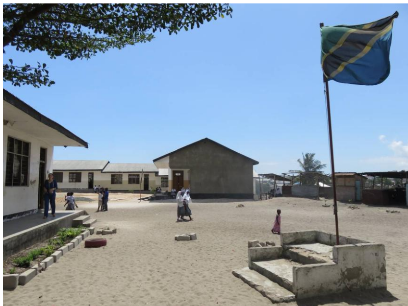
Fot. 1. Typowe podwórko szkolne i otaczające je budynki Mlimani Primary School
