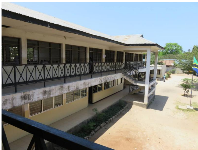
Fot. 3. Typowe podwórko i budynki szkolne Kinondoni Secondary School
